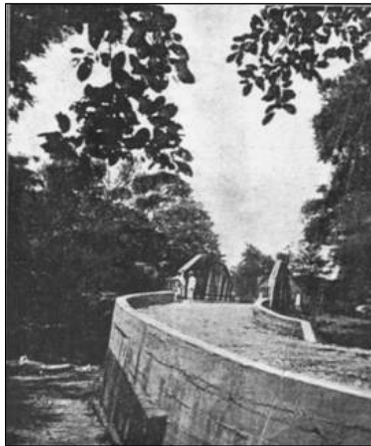
Imagen # 57 PUENTE SOBRE EL RÍO SARARE VISTO DESDE EL BAÑO GARRAPATICIDA
